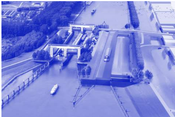
Verbreding Beatrixsluizen in het Lekkanaal
