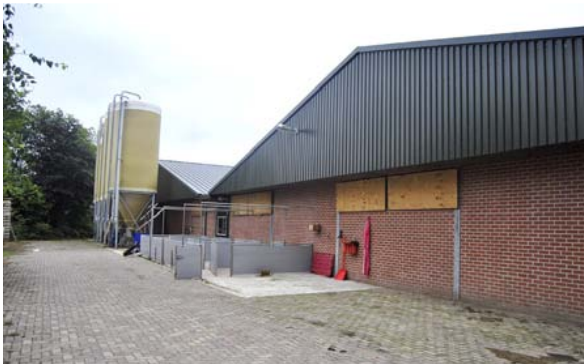
[vervangen door luchtfoto, res niet voldoende]
