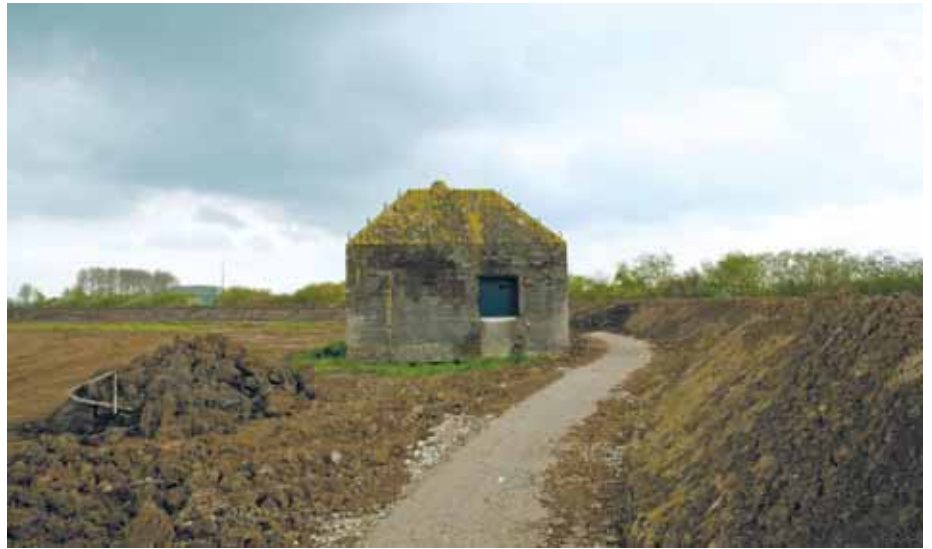
Nieuw wandelpad langs de Diefdijk..
