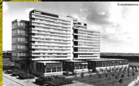
Het faculteitsgebouw Bouwkunde TU Delft (1970) is een ontwerp van het architectenbureau Van den Broek en Bakema.
