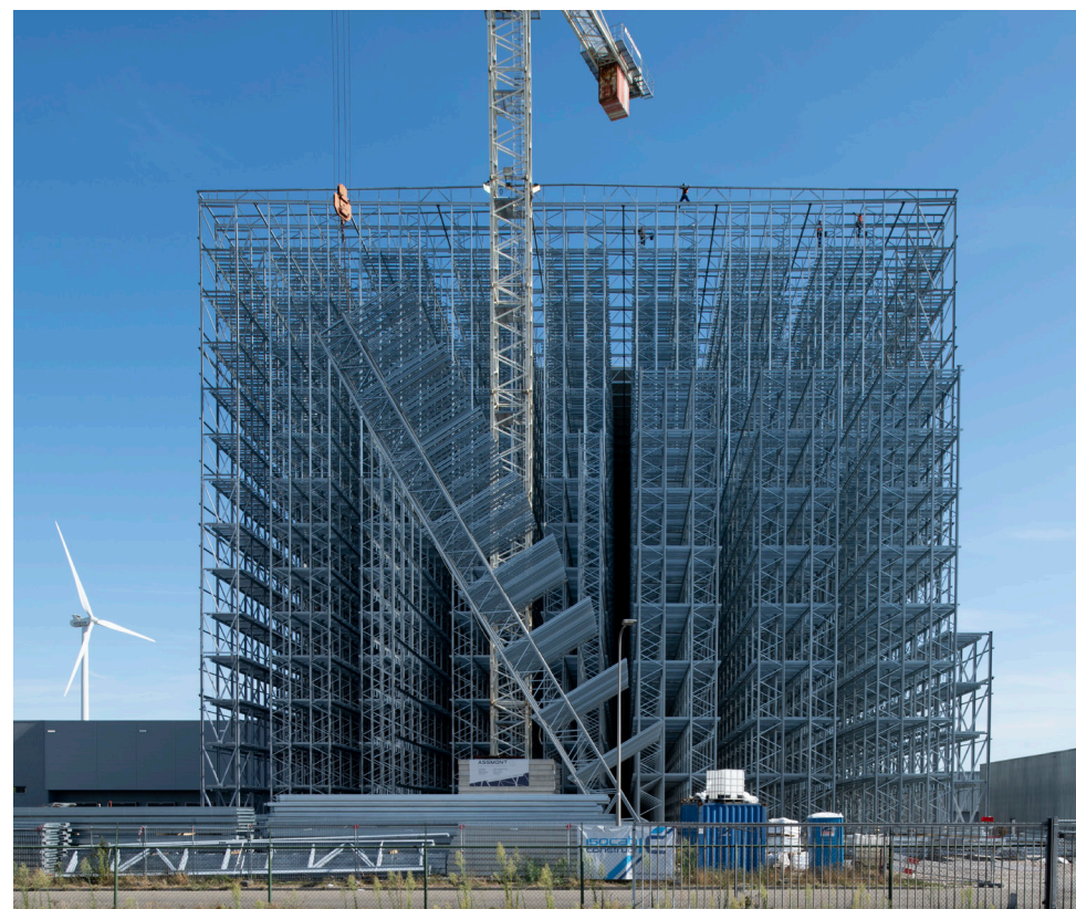
Afb. 1. Hoogbouw. Geautomatiseerde highbay friet-koelhuis in aanbouw, met racks als draagstructuur. Agristo, Tilburg. Foto: Rufus de Vries.
