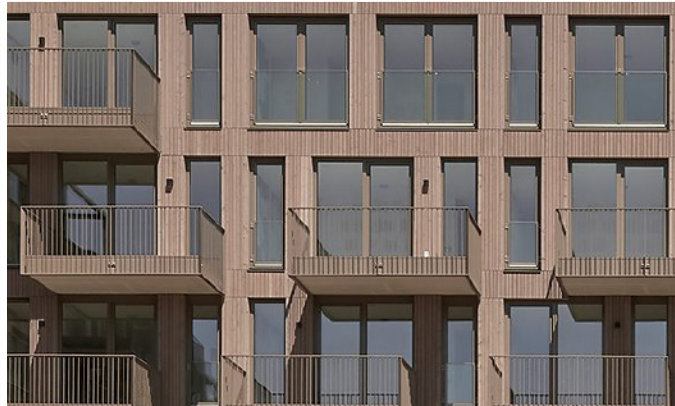
Afb. 92 - variatie in gevelopeningen
