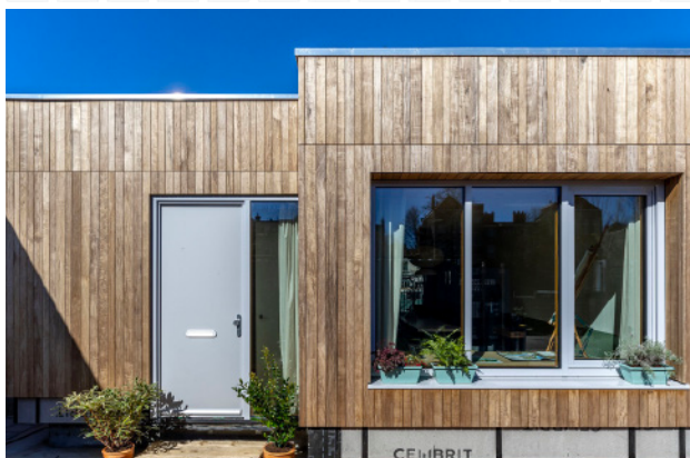
Afb. 81 - sprong in de gevel & diepe negge
