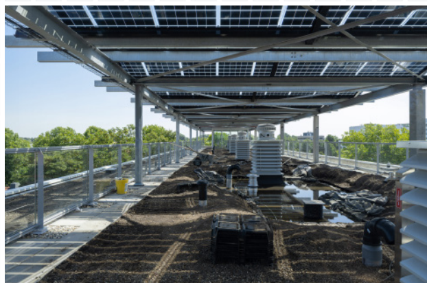
Afb. 46 - daktuin en installatiedak gecombineerd
