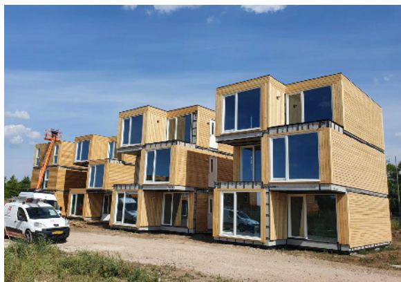
Afb. 34 - portiek met open trappenhuis
