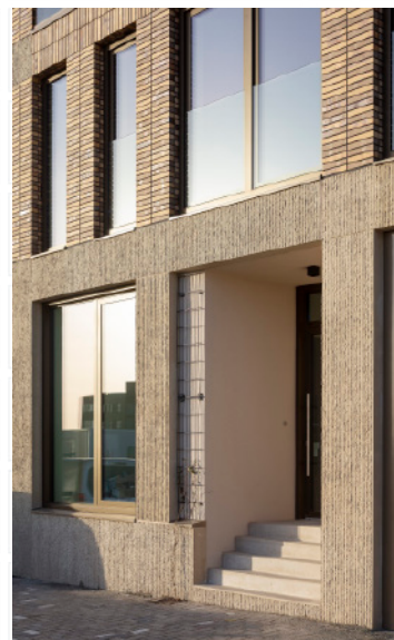
Afb. 79 - terugplaatsen van de entree
