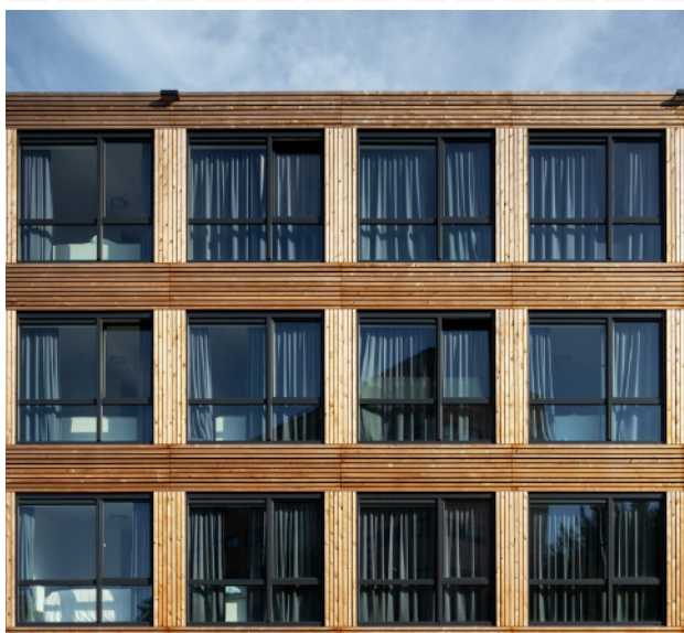
Afb. 84 - naden verborgen achter gevelbekleding
