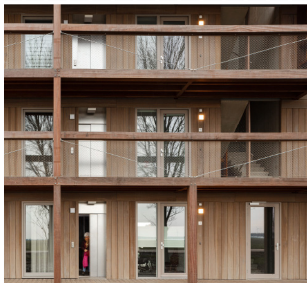
Afb. 32 - open trappenhuis opgenomen in het gebouw
