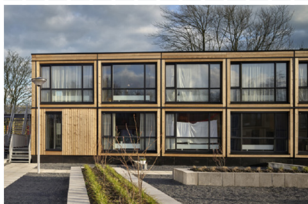
Afb. 83 - horizontale en verticale naden aangezet
