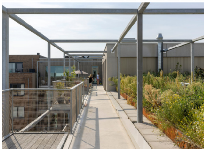
Afb. 43 - pergola als beëindiging en planten in bakken
