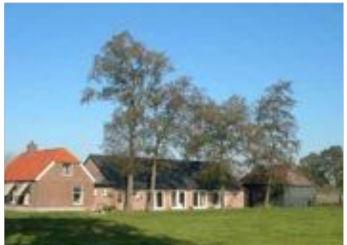
Deze oude varkensstal in Dalfsen is vervangen door een nieuwe 'schuurwoning'
