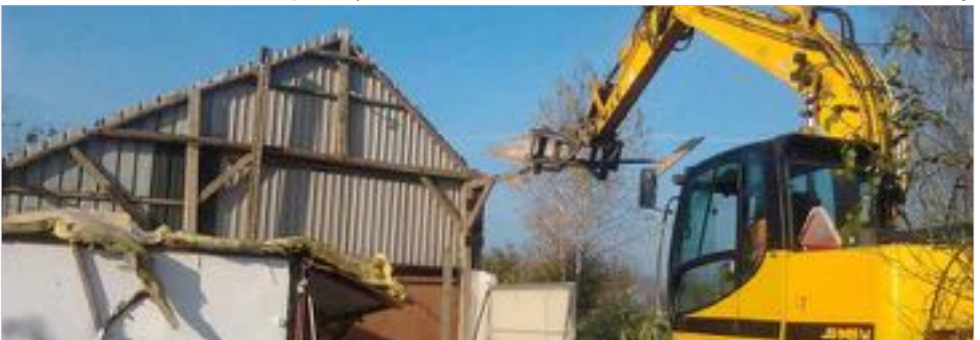
Sloop van schuur
