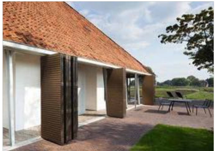
Schuur wordt woning in IJlst - Jelle de Jong architecten
