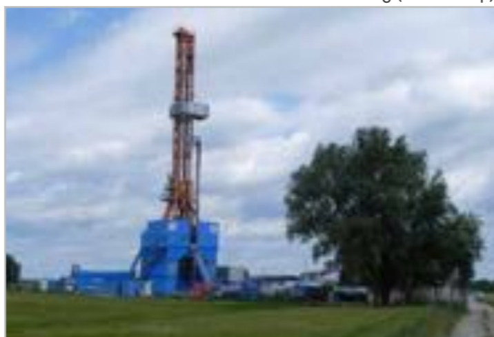
Boortoren voor geothermie
