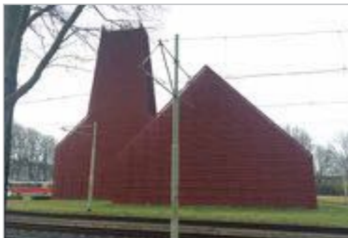
Geothermie centrale in Den Haag (middeldiep)
