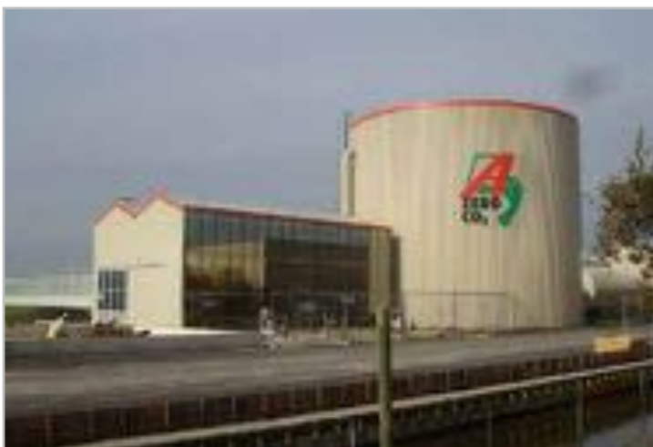
Geothermie installatie in Pijnacker (middeldiep)
