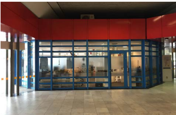
"Transparante wanden" zijn toe aan moderniseringslag.
