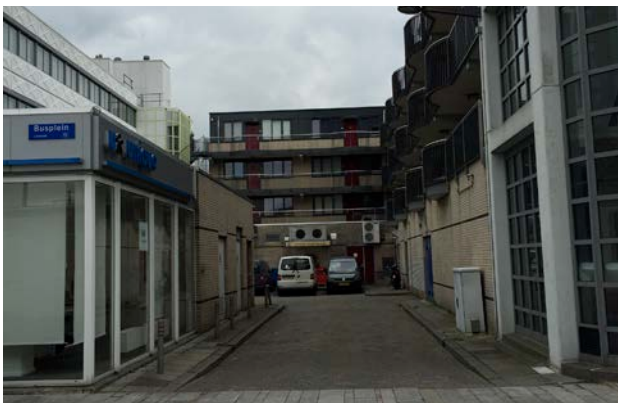
Toegang en doorzicht naar onaantrekkelijk binnengebied.
