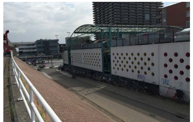
Willekeurig gestalde fietsen tegen blinde gevel.
