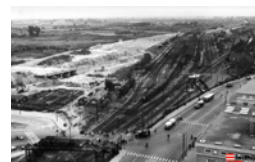
aanleg verhoogd spoor 1947
