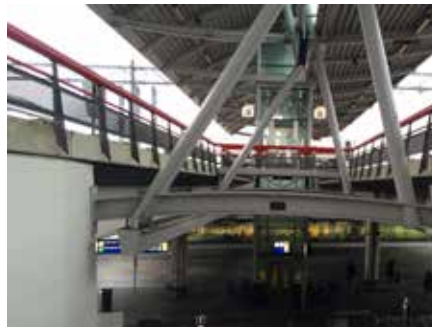
entree van zuidzijde gezien vanaf perron
