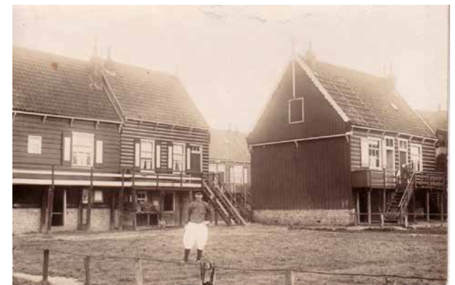
Paalwoningen, deels dichtgebouwd
