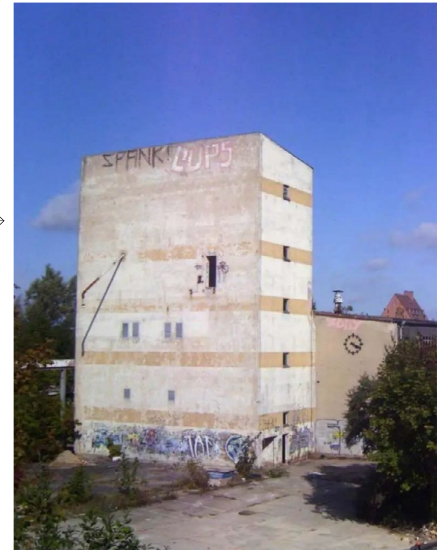
Silo toren ©Schelfbauhütte
