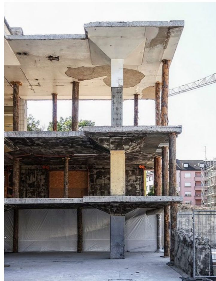
Houten kolommen ondersteunen de betonnen vloerplaten tijdens de bouw ©Esch Sintzel Architekten
