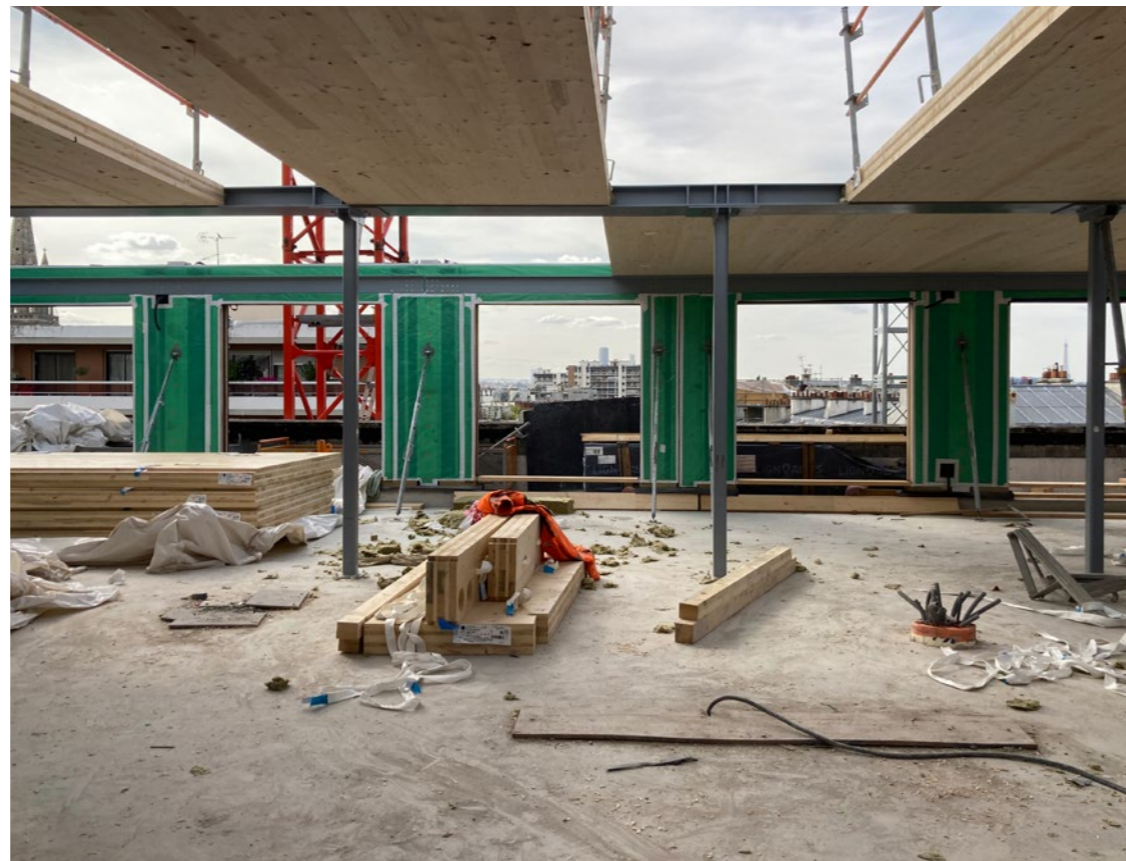
CLT vloerplaten ©Atelier Tequi Architectes
