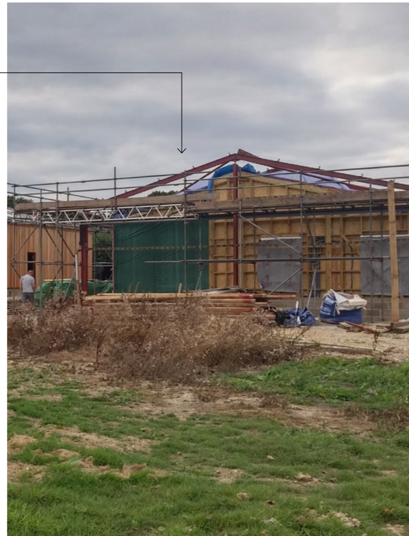
De schuren tijdens de bouw. Behouden staal in rood, nieuwe HSB achter ©Studio Bark
