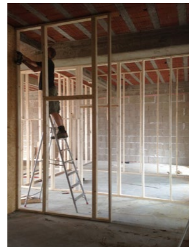
HSB muren als binnenwanden in appartementen
