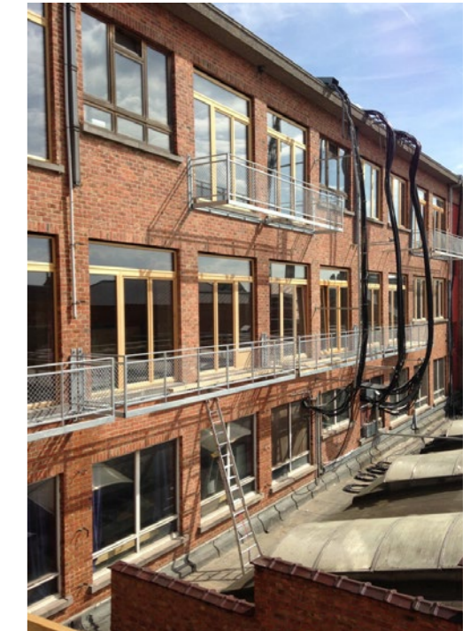
Nieuwe kozijnen, ramen en balkons in de westgevel
