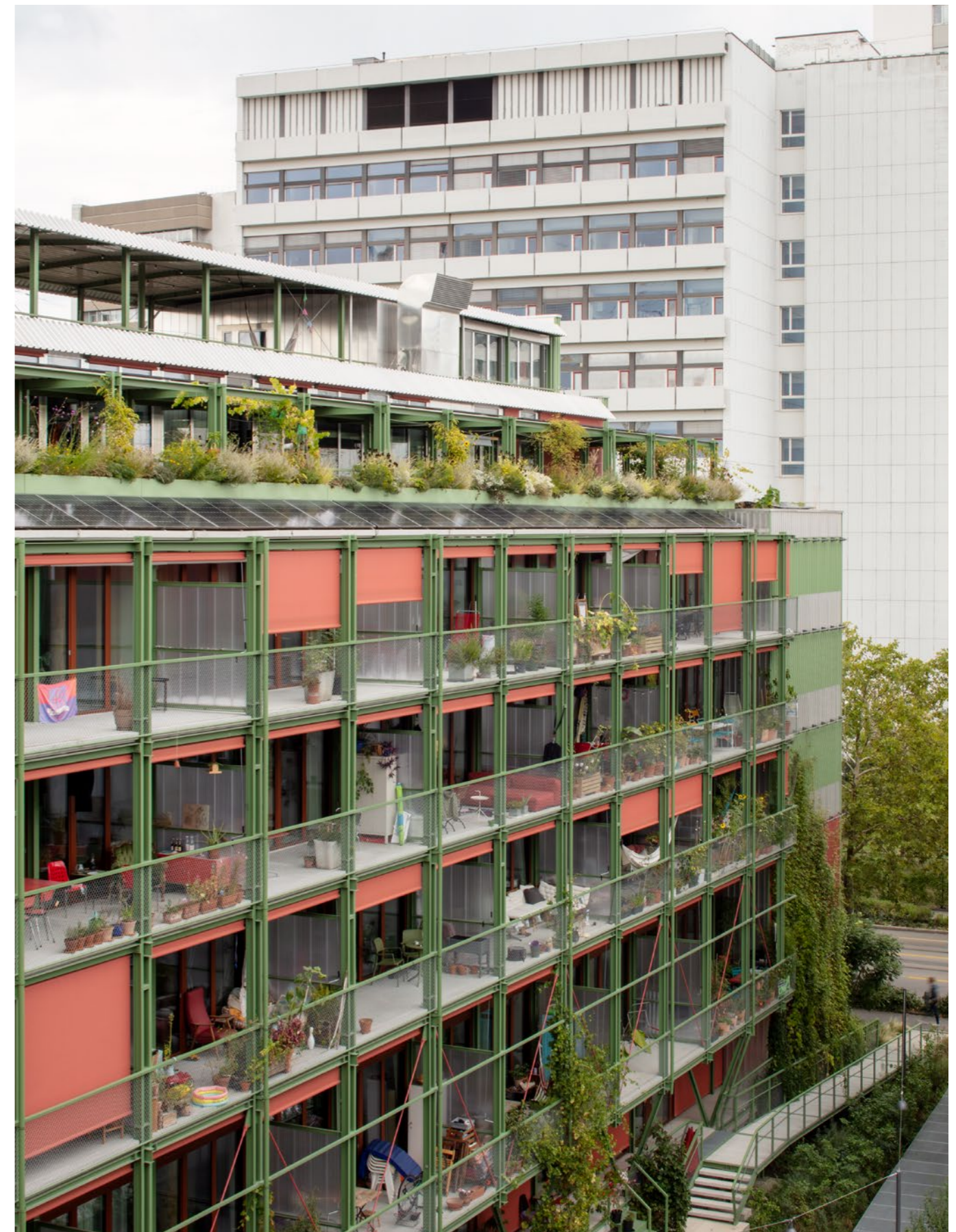
Balkons zijn demontabel, met oog op circulariteit ©Paola Corsini
