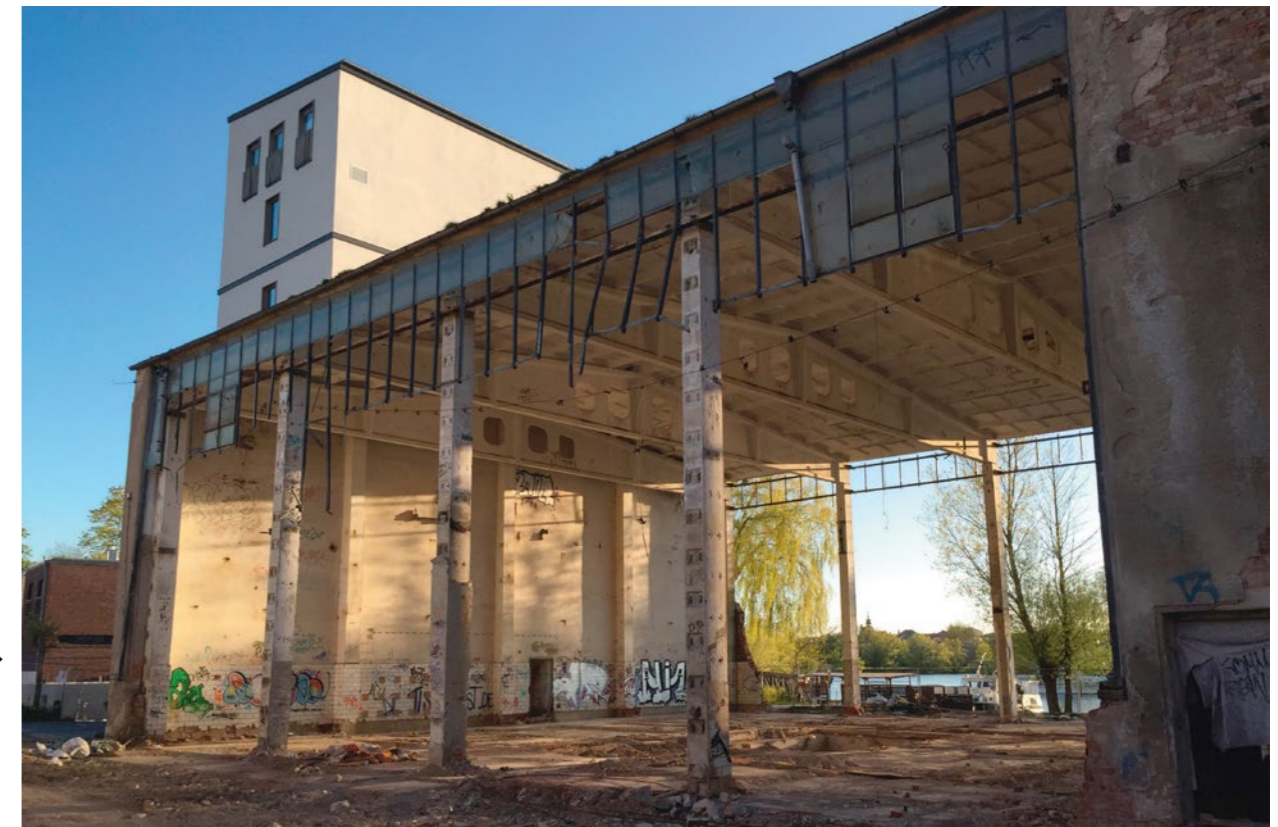
Brouwerij vóór de transformatie, met getransformeerde toren achter ©Schelfbauhütte
