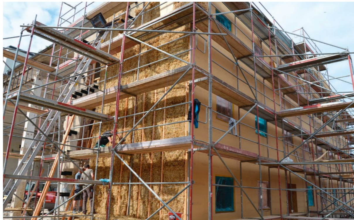
Tijdens de bouw - stro isolatie met houtvezelstucplaat ©Schelfbauhütte
