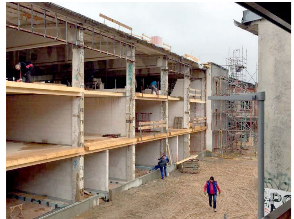
Tijdens de bouw - CLT vloerplaten ©Schelfbauhütte
