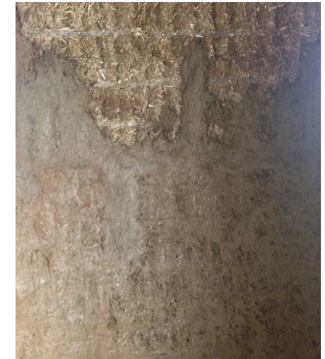
Zelf leemstuc onderlaag aanbrengen op stromuren. De kalkstuc laag is gedaan door een professionele stucadoor.
