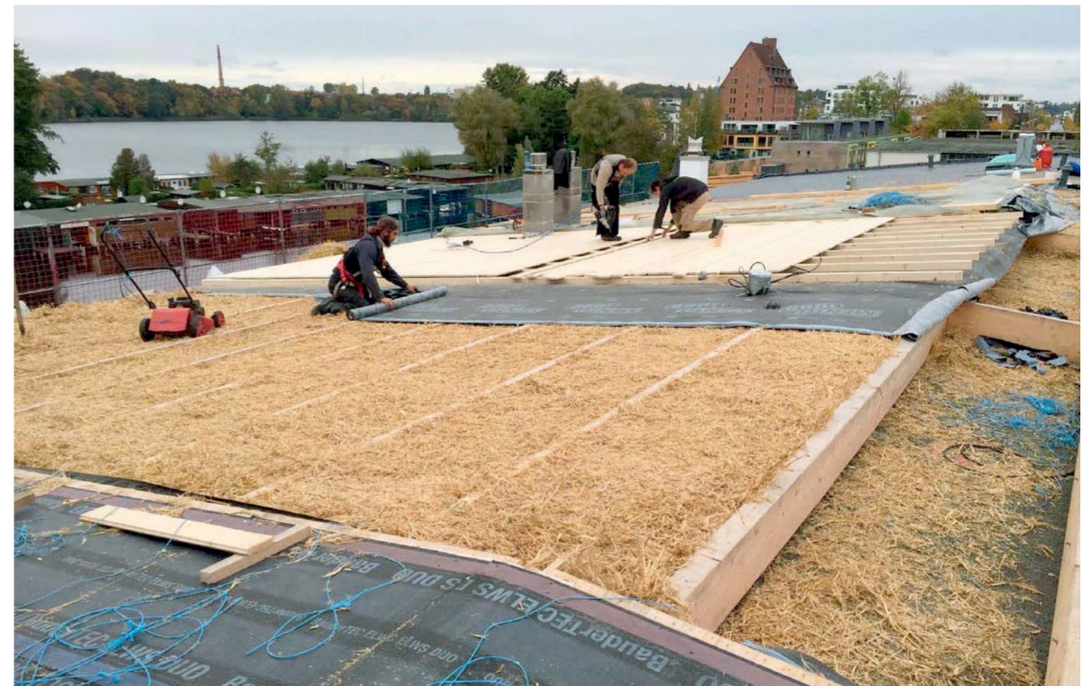
Tijdens de bouw - stro isolatie op het dak ©Schelfbauhütte
