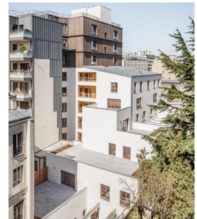
Beeld van achtergevels na voltooiing © 11h45
