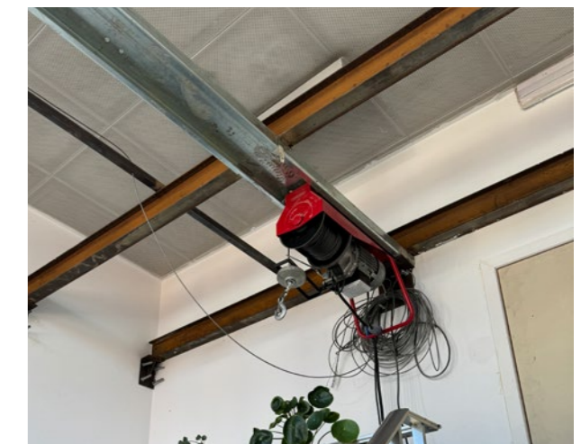
De eigenaren installeerden een takel om zware materialen naar boven te tillen.
