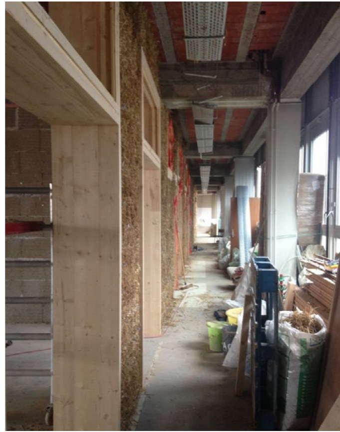
Galerij in aanbouw
