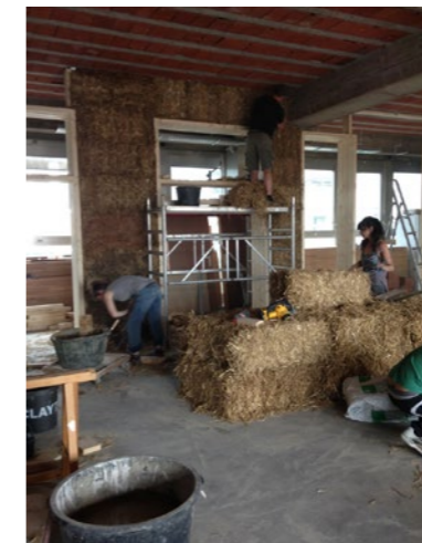
Stro aanbrengen in scheidingswand naar galerij
