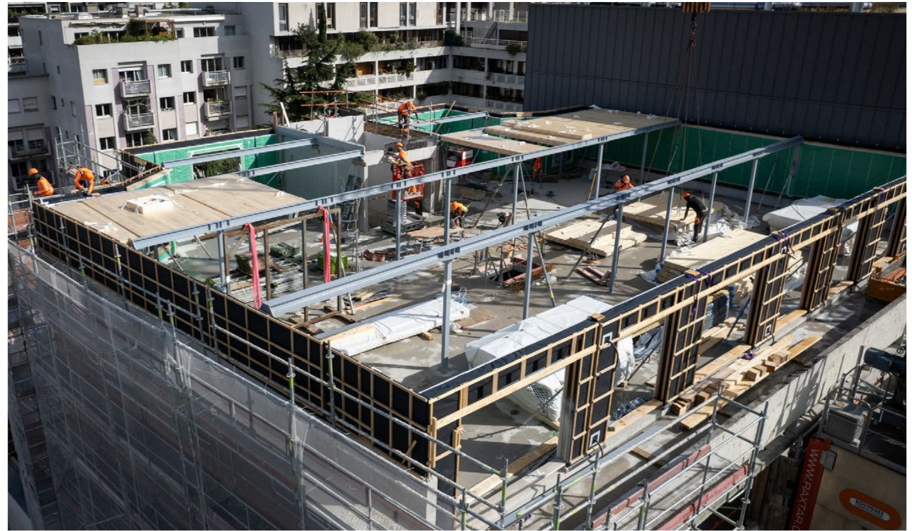
Optopping in HSB en CLT ©Atelier Tequi Architectes
