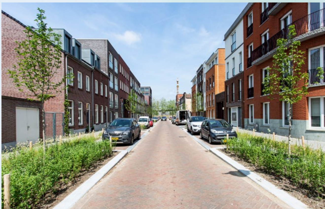
Afbeelding 120 & 121. De Menno van Coehoornstraat was de meest versteende straat van Breda en scoorde rood op de meetlat van het Urban Heat Island-effect (foto rechts). Door vergroening, met veel groenvakken, 18 bomen gecombineerd met infiltratie en wateropvang, is de straat klimaatbestendig gemaakt, en scoort deze nu groen binnen dezelfde index (foto links). Cool Towns, Breda (2022).
