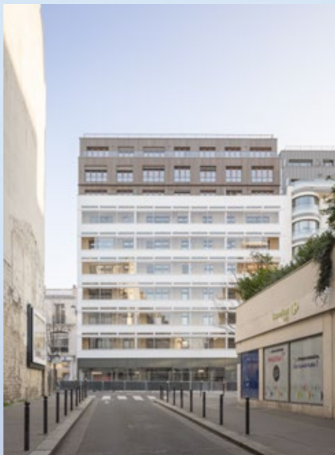
Garage Parmentier, Atelier Téqui Architectes Parijs, Frankrijk. Beeld: Schnepf Renou
