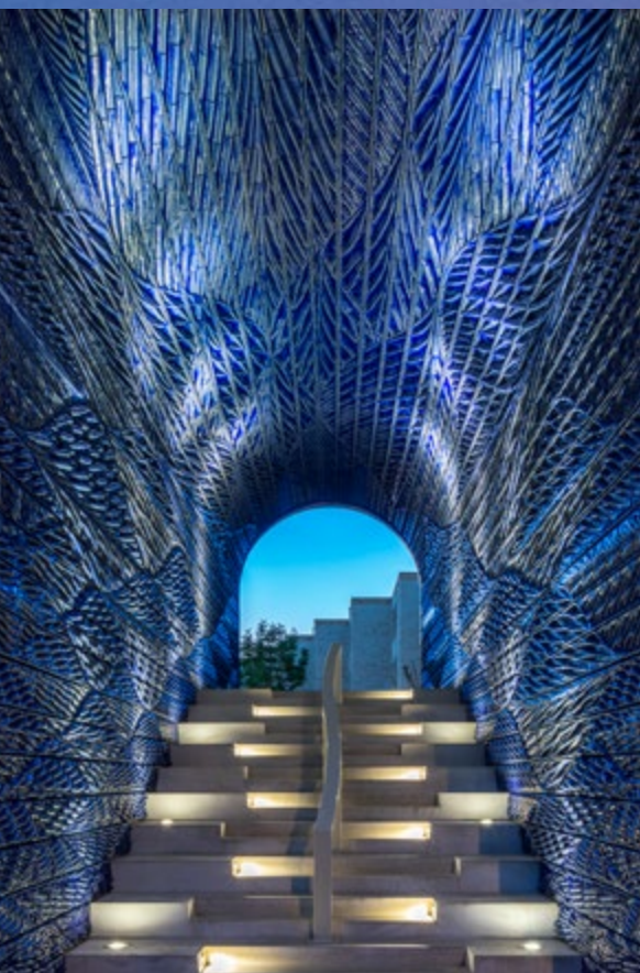
Afbeelding 47 & 48. Poortmeesters in Delft (2023) YVA – architectuur & stedenbouw, is een stedelijk woonblok met twee grote poorten die de straat verbinden met een groene binnentuin. De robuuste baksteenarchitectuur wordt doorbroken door een stadspoort met Delfts blauwe 3D-geprinte tegels van Studio RAP, waarachter een verhoogde, groene en gemeenschappelijke oase ligt. Foto: Sjaak Henselmans
