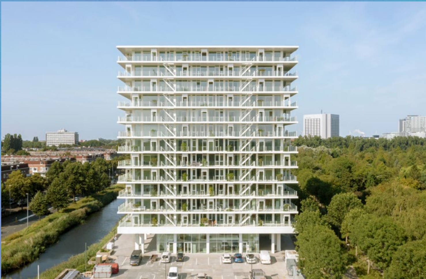
Afbeelding 62. De Voortuinen [2021] in Amsterdam is een voormalig ING kantoor dat is getransformeerd tot wooncomplex. De bestaande constructie is behouden en aangepast. In de toren zitten nu 94 woningen voorzien van rondlopende balkons met daarin plantenbakken voor boompjes. Ontwerp: Elephant. Foto: Marcel van der Burg.
