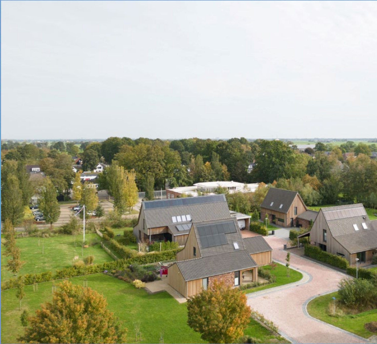
Afbeelding 55. Op het terrein van boerderij 'Werklust' in Niekerk zijn vier woningen gerealiseerd rondom een hof. De boerderij is behouden, gerenoveerd en herbestemd. Ontwerp: SKA architecten. Foto: Ronald Zijlstra.
