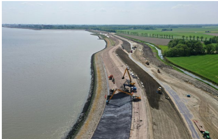
Dijkversterking Eemshaven-Delfzijl. © Rijkswaterstaat
